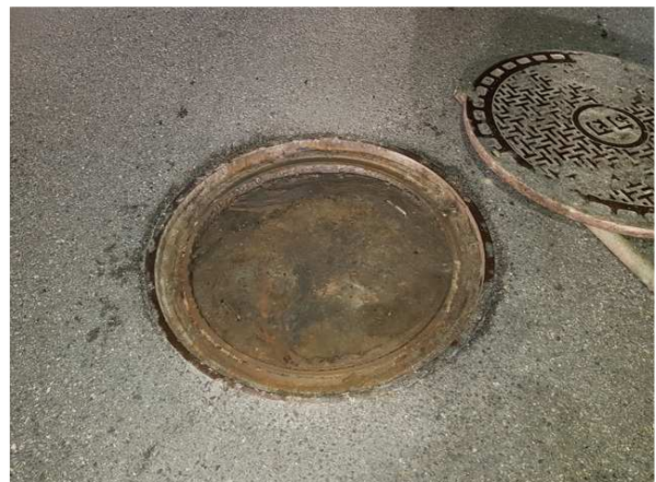
내용 맨홀 내,외부 뚜껑 상태양호
