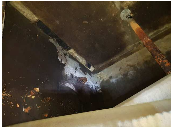
내용 벽체 박락 보수부 전경
