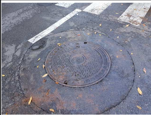
내용 포장부 아스콘망상균열 보수부 전경
