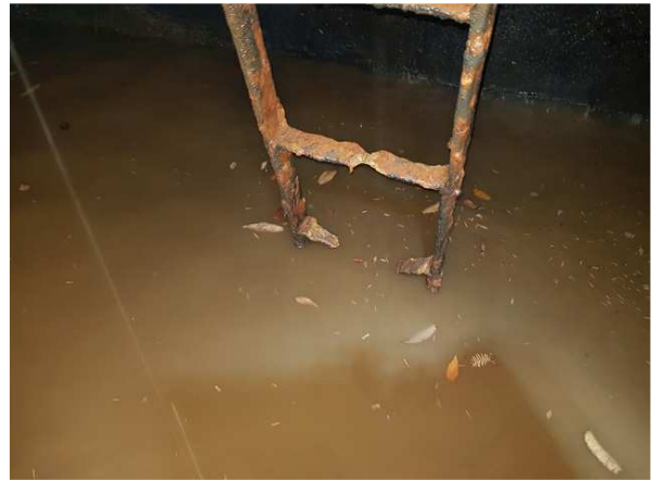
내용 하부 사다리 하부 파손
